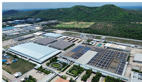
泰国いすゞ自動車（IMCT）の太陽光発電設備
